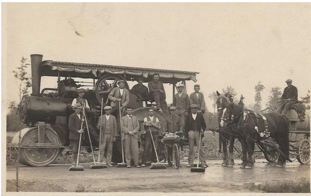
104/2017 – 20.996 – rekonstrukce silnice - Malín, 1929.
