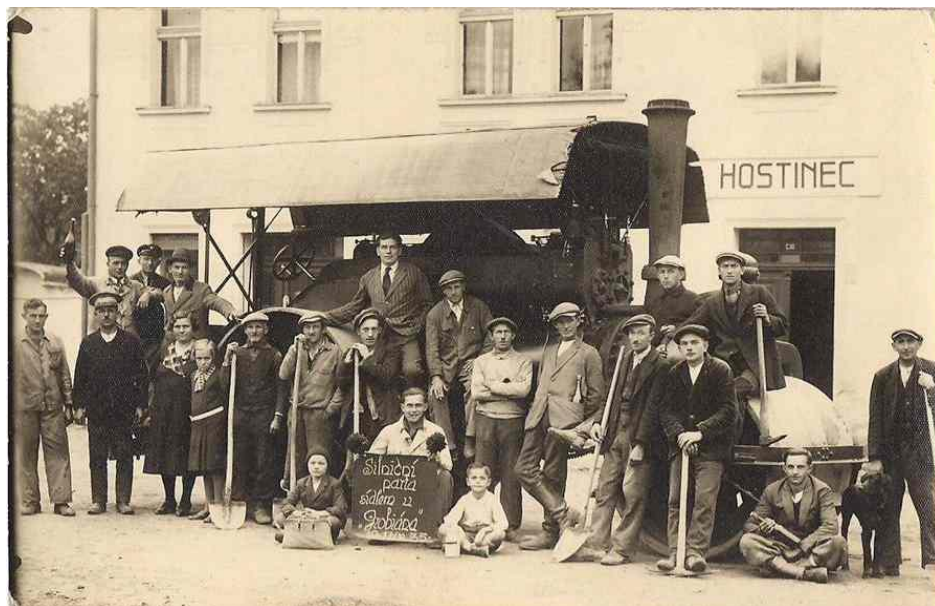
Pohlednice – silniční parta, 1935, inv.č. 20.158
