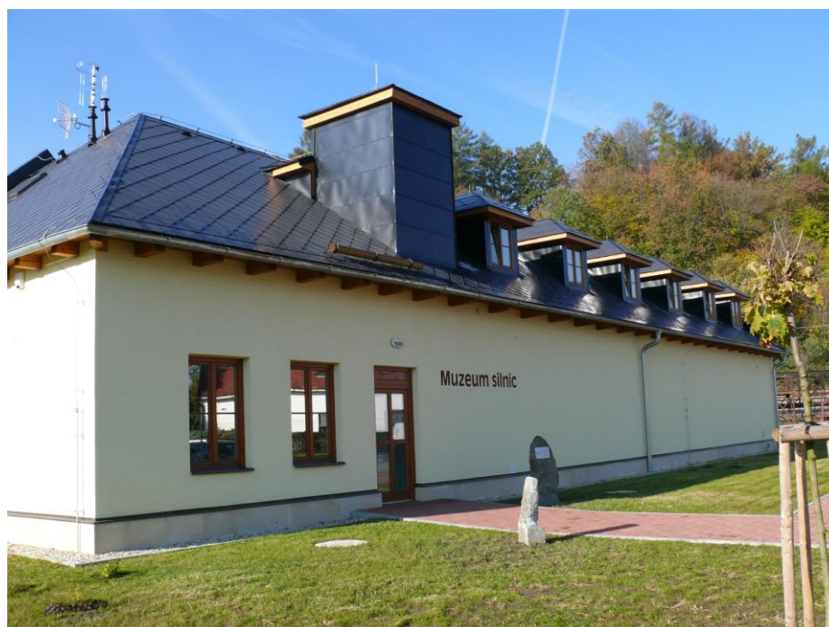
Rekonstruovaný objekt muzea – říjen 2010
