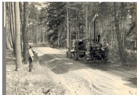
Stavba silnice, 50. – 60. léta 20.st., 20.512
