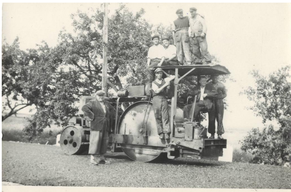
Fotografie, stavba silnice, 30. léta 20. století, vlastní sběr, inv. č. 20.1184
